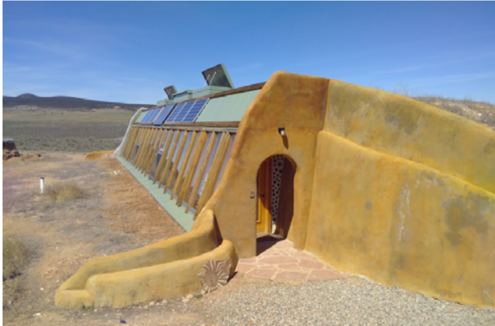
La face sud du Earthship est une grande baie vitrée. Aucune fenêtre ne se trouve au nord, à l'est et à l'ouest. L'inclinaison des fenêtres permet de capter un peu plus d'énergie solaire (peu significatif). Surtout, cela permet aux plantes à l'intérieur de croître dans des conditions optimales (serre).
