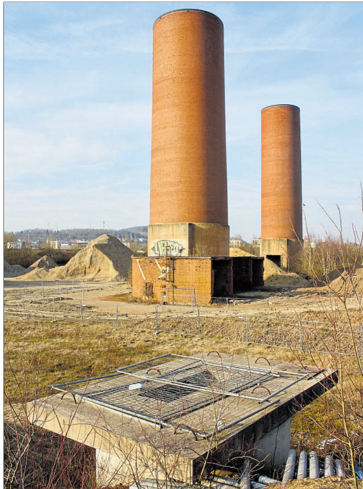
Die in 2002 freigelegte und mit einem Betondeckel abgesicherte Mineralwasserquelle liegt direkt vor den Schornsteinen. (FOTO: INNA GANSCHOW)
