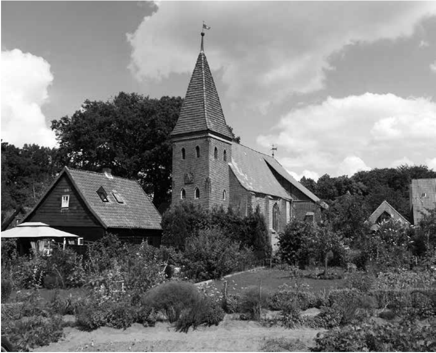
Abb. 8: Kapelle der Lüneburger Leproserie St. Nikolai (Ich danke Alexandra Druzynski von Boetticher für die freundliche Überlassung des Fotos.)
