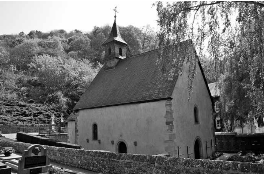
Abb. 4: Kapelle des ehemaligen Luxemburger Leprosoriums. Es handelt sich um einen einschiffigen Bau mit rechteckiger Apsis und einem Dachreiter. (Foto: Martin Uhrmacher, 2011)
