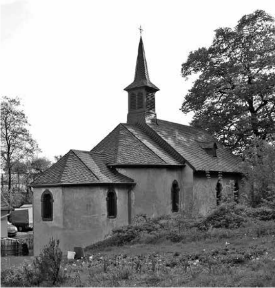
Abb. 3: Kapelle des Trierer Leprosoriums St. Jost mit doppelt gestaffelter Apsis und Dachreiter (Foto: Martin Uhrmacher, 2011)
