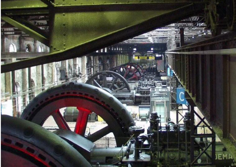
Gasgebläsehaus 2002, Einblick vom neuen Besucherzugang, vor der Verdunklung und Verstellung der Halle mit Vorhängen und Ausstellungswänden. Foto: E. Mendgen
