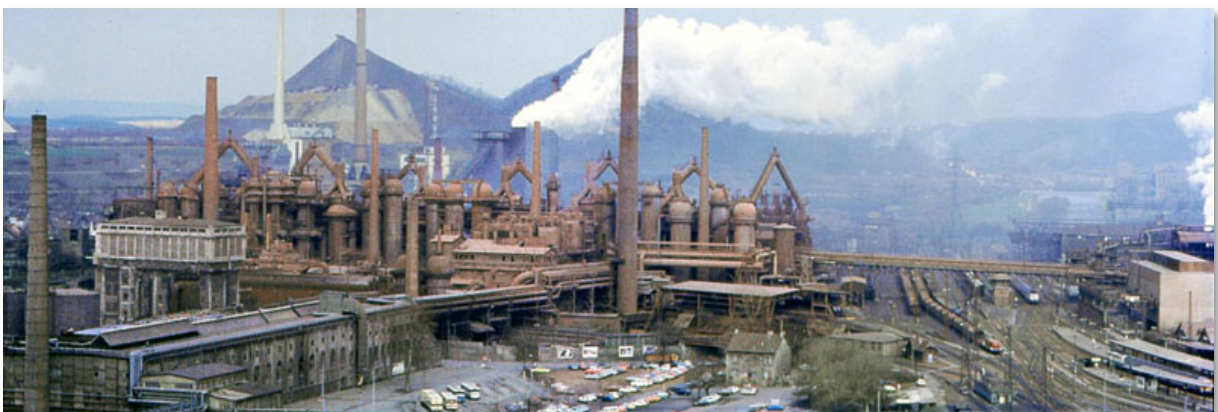
Hochofenanlage 1986, kurz vor der Stilllegung, mit u.a. 6 Hochöfen incl. den davor stehenden Winderhitzern, Wasserturm (links), Gasgebläsehaus (im Vordergrund), Reste des alten Stahlwerkes (recht aussen) und den Schlackehalden (im Hintergrund). Foto: N. Mendgen
