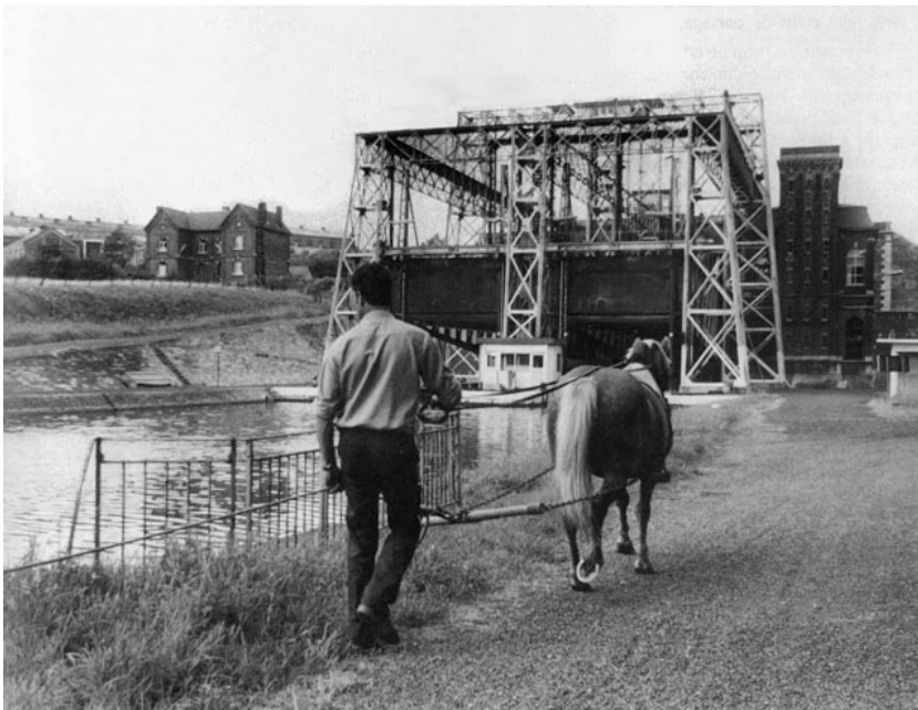
Treidler beim Schiffshebewerk am Canal du Centre. Quelle: Gaillez 1990
