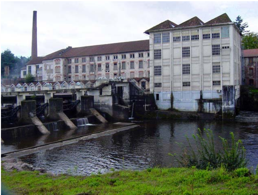
Das Stauwehr der ehemaligen Weberei Hartmann in Saint-Laurent bei Épinal (Lothringen), dient heute der Stromerzeugung mit einem Kleinwasserkraftwerk. Foto: Edelblutte 2004
