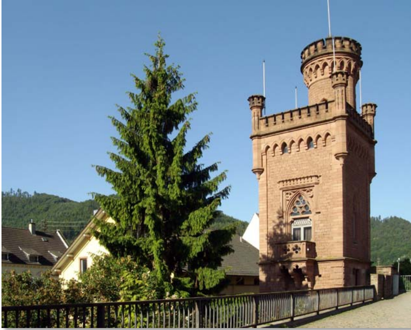
Der Wasserturm der ehemaligen Fabrik JJ. Marx Filz AG in Lambrecht (Pfalz), errichtet 1885. Foto: Edelblutte 2011
