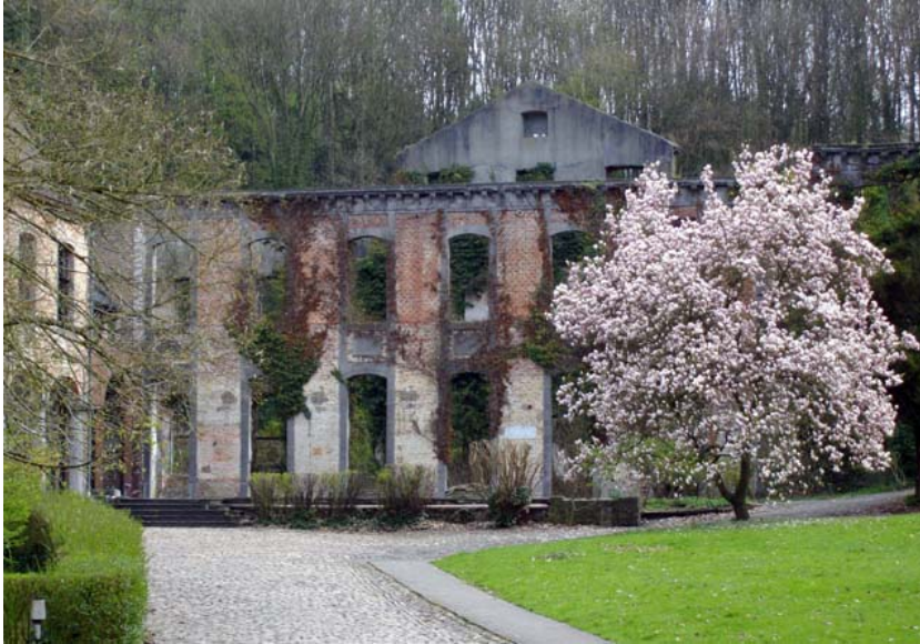
Die Ruinen des Hauptgebäudes der ehemaligen Baumwollspinnerei Saint-Denis in Obourg, Gemeinde Mons (Wallonie). Foto: Edelblutte 2011
