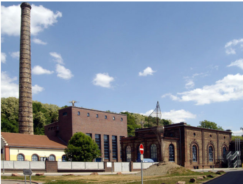
Ein Teil der 1857 errichteten Alten Kammgarn-Spinnerei in Kaiserslautern, die heute als bekanntes Kulturzentrum dient. Foto: Edelblutte 2011
