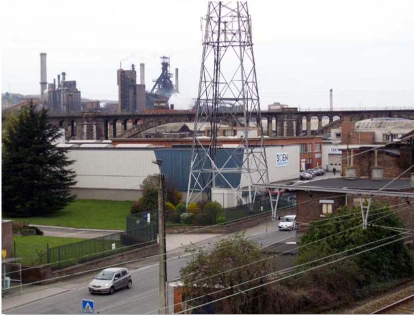
Sioen Felt and Filtration (ex-Nordifa) in Scllessin bei Liège, Fabrik zur Herstellung technischer Filze. Foto: Edelblutte 2011
