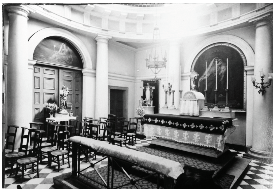
Figure 6 : Chapelle de l'hospice de l'Infirmerie (1930) 68
