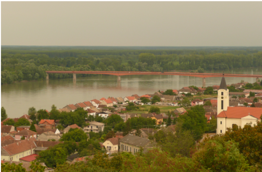
Figure 48 – Le pont sur le Danube entre Batina (CRO) et Beždan (SRB), vu depuis Batina.
