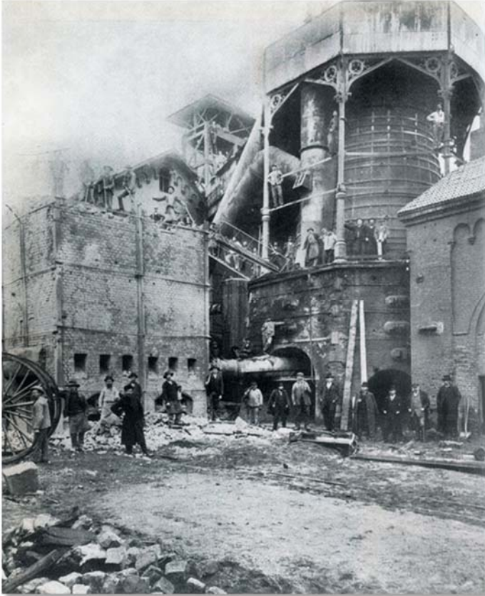
Dommeldange, Abriss des 1865 erbauten Hochofens, 1901. Quelle: ARBED. Un demi-siècle d'histoire industrielle 1911-1964, o.O. [1964], S. 22
