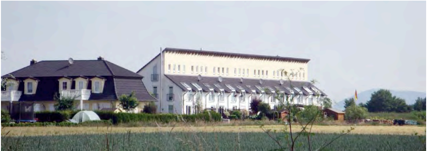
Abb. 105: Neubau in Fritzlar, Kassel
