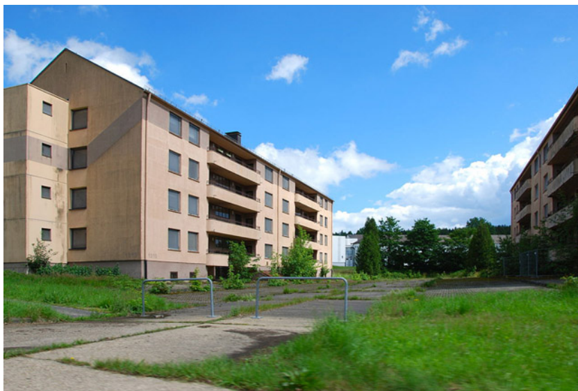
Ehemalige Wohngebäude amerikanischer Soldaten am ehemaligen Militärflug- hafen Hahn (Hunsrück) Foto: Florian Decker cc (be- arbeitet)
